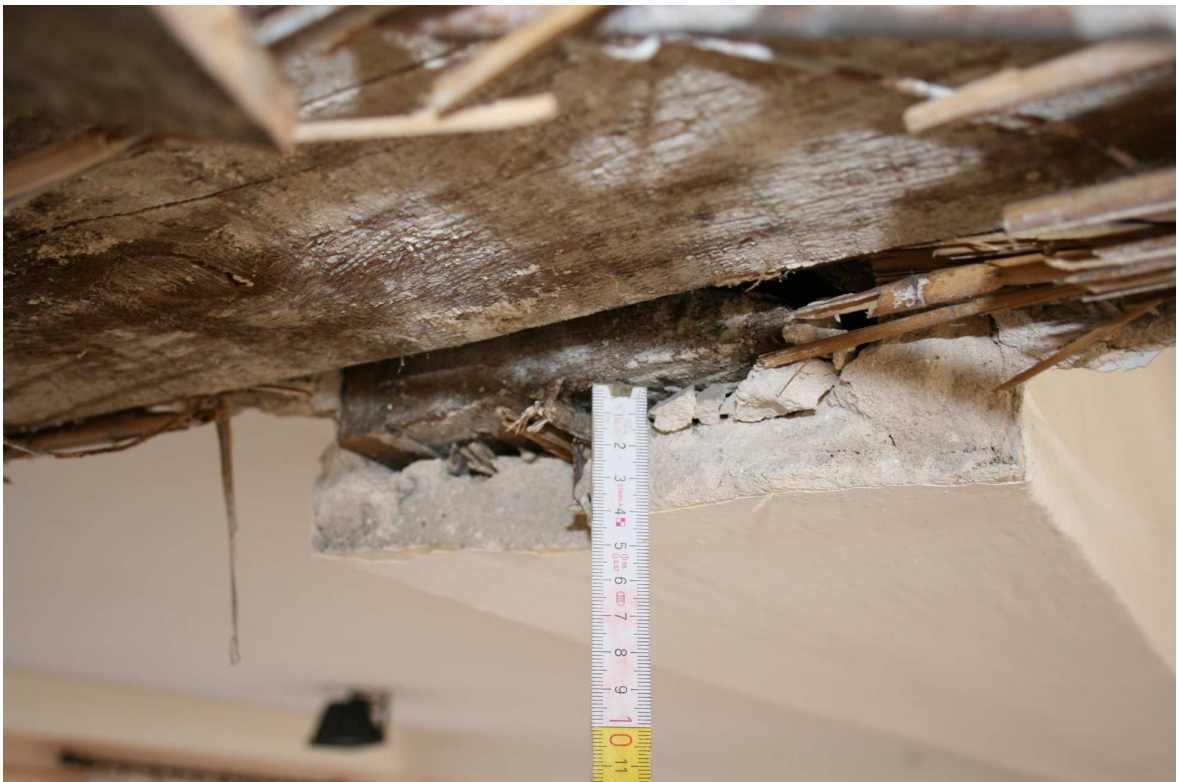
FOT.07. Tynk cementowo-wapienny gr. 4cm na macie trzcinowej, wykonany na atrapie belki wykonanej z desek gr. 28mm.
