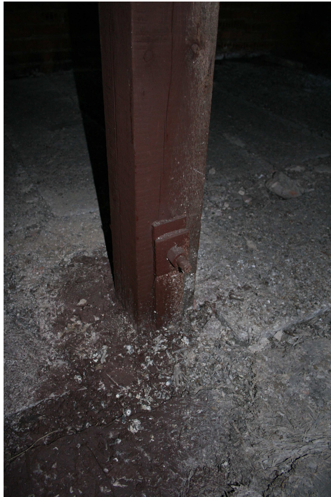
FOT.14. Chomąto – płaskownik łączący ściąg z wieszakiem.
