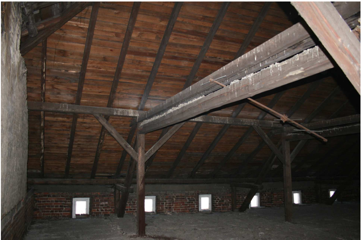
FOT.11. Więźba dachowa poszyta jest pełnym deskowaniem.
