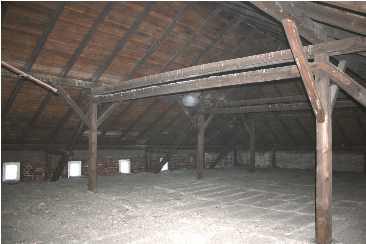
FOT.12. Ogólny widok poddasza.
