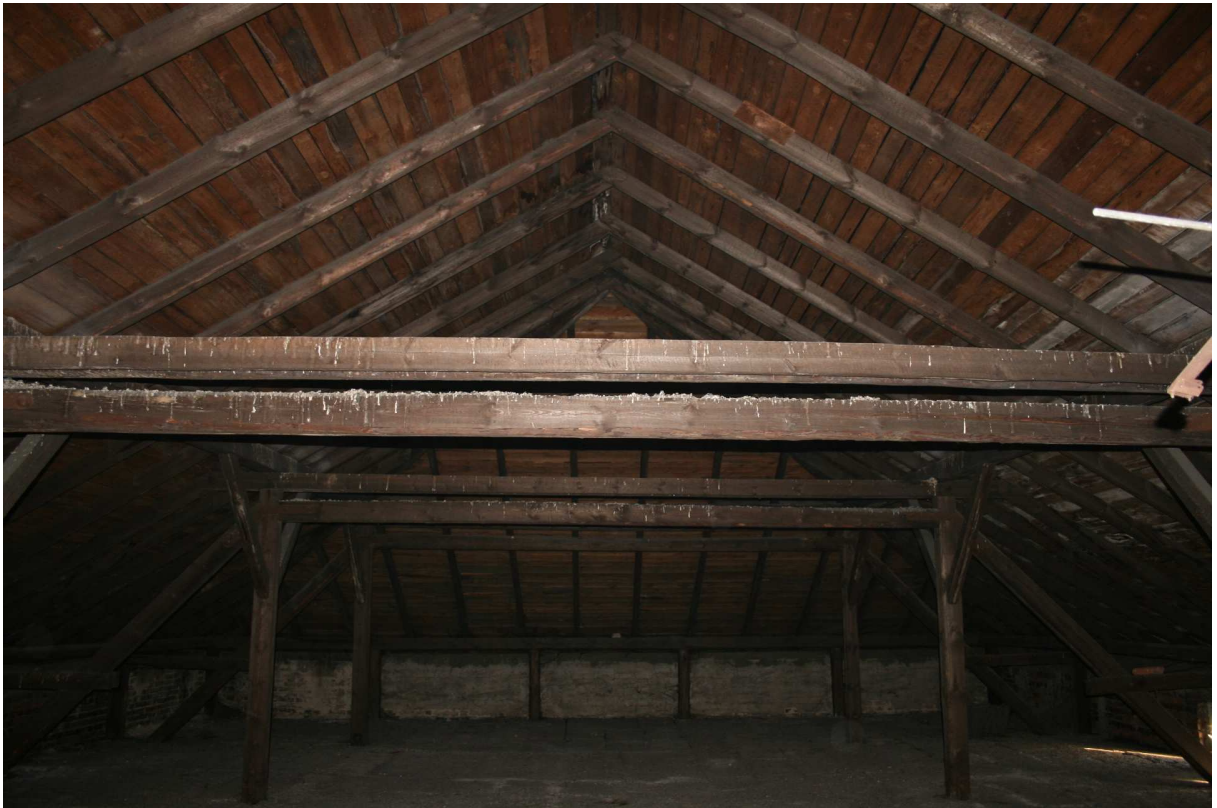
FOT.10. Konstrukcja wieszarowa dachu.
